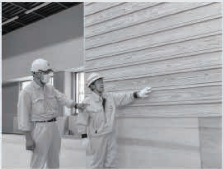
工事関係者から説明を受ける渡邊町長
