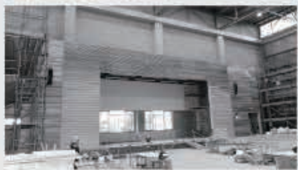
体育館内部の様子。ステージ周辺は地場産の杉材をふんだんに使い、重厚な仕上がりとなっています。
